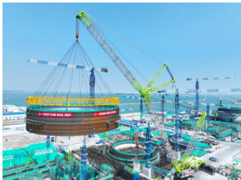
漳州核电4RRC钢衬里模块二吊装就位完成
