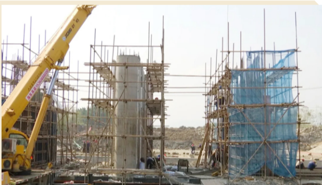
东方水闸除险加固工程项目建设现场
