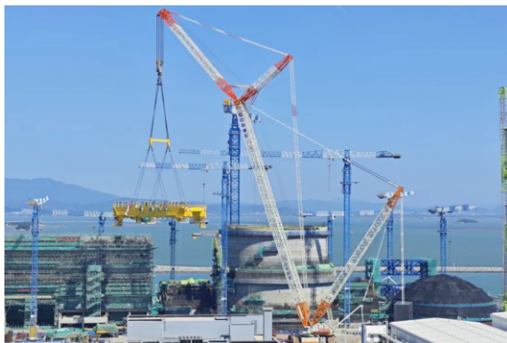
漳州核电3号机组环吊桥架整体吊装就位
