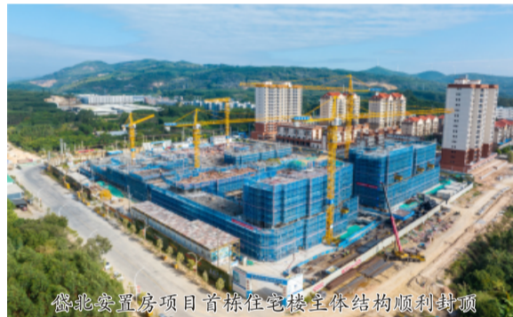
岱北安置房项目首栋住宅楼主体结构顺利封顶
