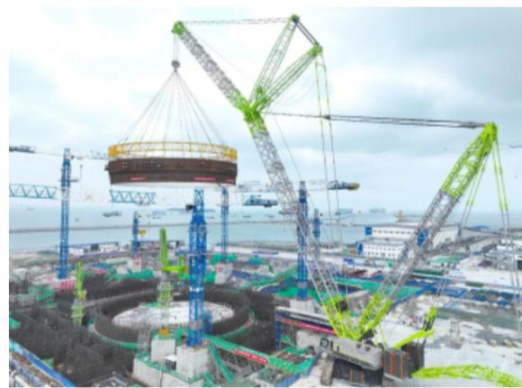
漳州核电3号机组反应堆厂房安全壳钢衬里模块一吊装成功
