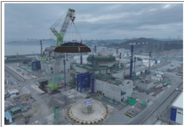
中核集团漳州核电2号机组外层安全壳穹顶钢衬里成功吊装
