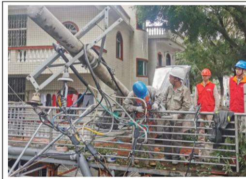
抢修人员正对霞洲花圃配变低压线路B号杆断杆进行抢修作业
