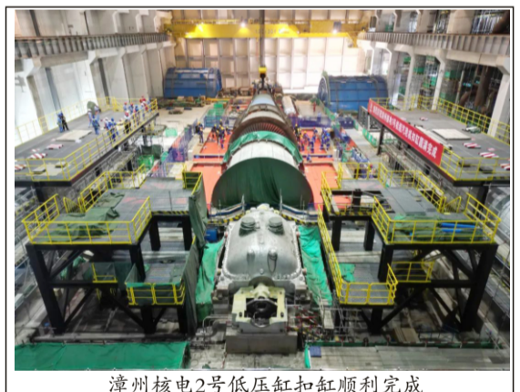
漳州核电2号低压缸扣缸顺利完成
