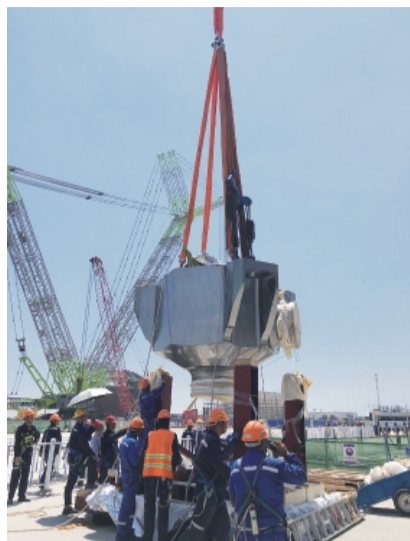
漳州核电2号机组首台一环主泵泵壳吊装过程
