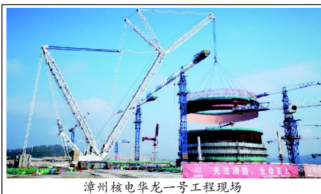
漳州核电华龙一号工程现场
