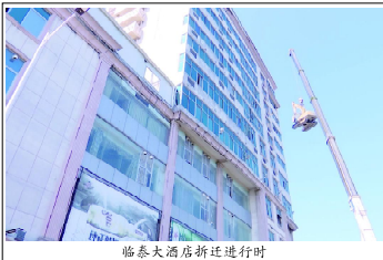
临泰大酒店拆迁进行时
