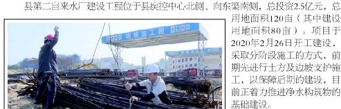
县第二自来水厂施工现场
