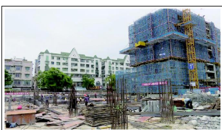
旧实小片区改造建设项目二期工程施工现场
