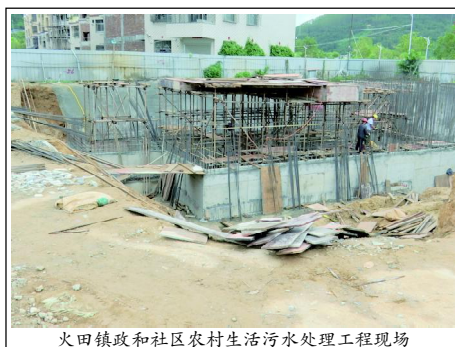
火田镇政和社区农村生活污水施工现场
