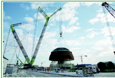
华龙一号批量化首堆机组内穹顶吊装
