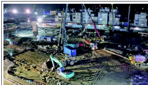
下港片区棚户区改造建设项目建设现场
